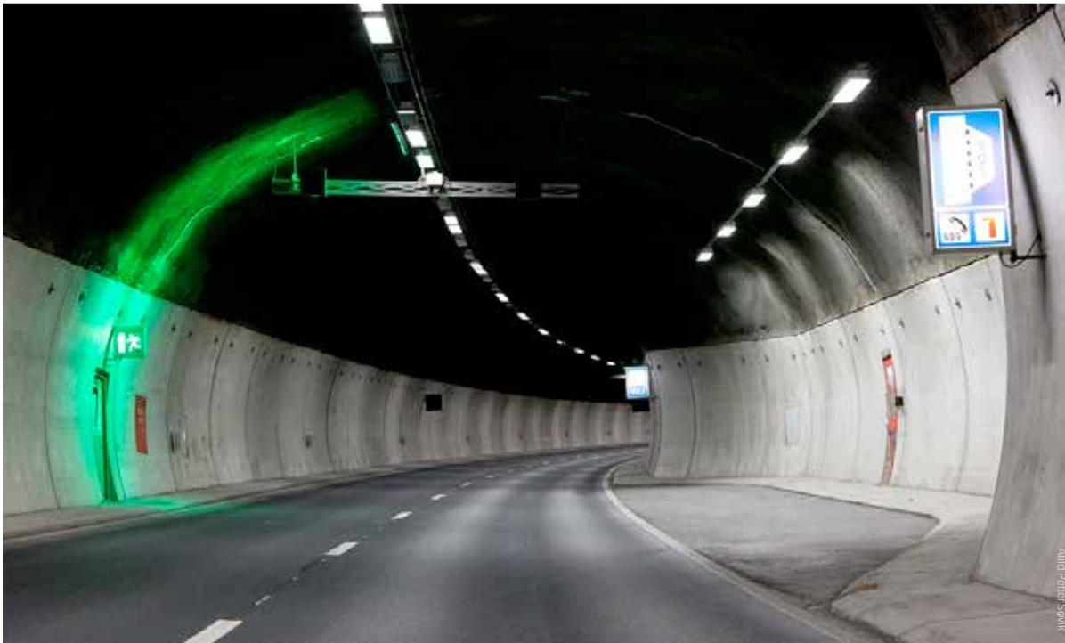
**Туннель с освещенным аварийным выходом, нишей для аварийной остановки и аварийным телефоном / огнетушителем**
